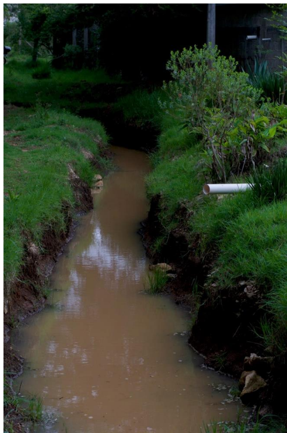
Zanja de infiltración (Martín López López, 2021).
